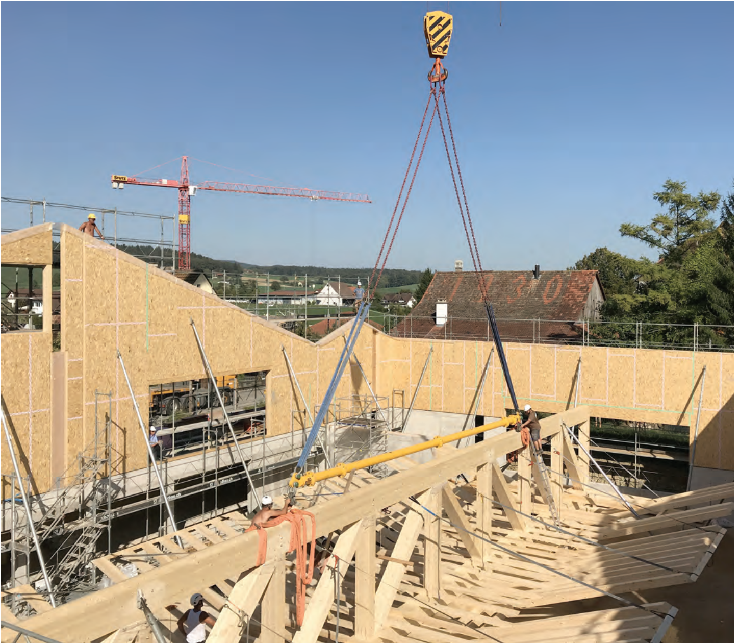
Neubau Mehrzweckhalle Pfyn, Aufrichten Fachwerkträger, September 2018
