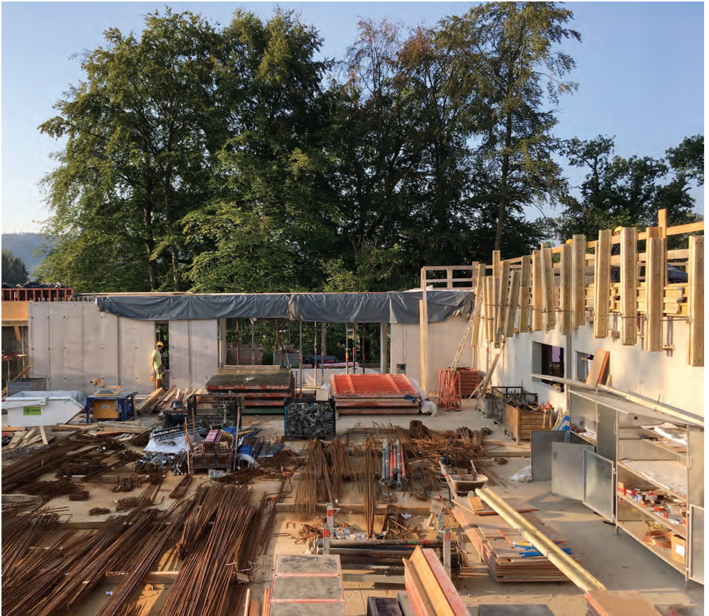
Neubau Mehrzweckhalle Pfyn, Materiallager Baumeister, August 2018
