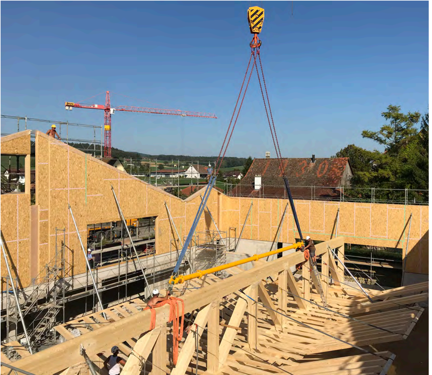
Neubau Mehrzweckhalle Pfyn, Aufrichten Fachwerkträger, September 2018
