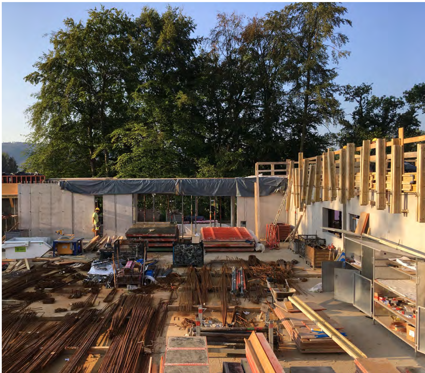
Neubau Mehrzweckhalle Pfyn, Materiallager Baumeister, August 2018
